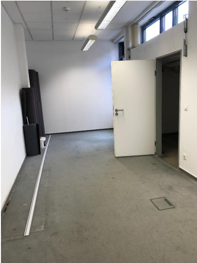
Die Büros der Mitarbeiter:innen bekommen einen neuen Anstrich und Teppichboden.
