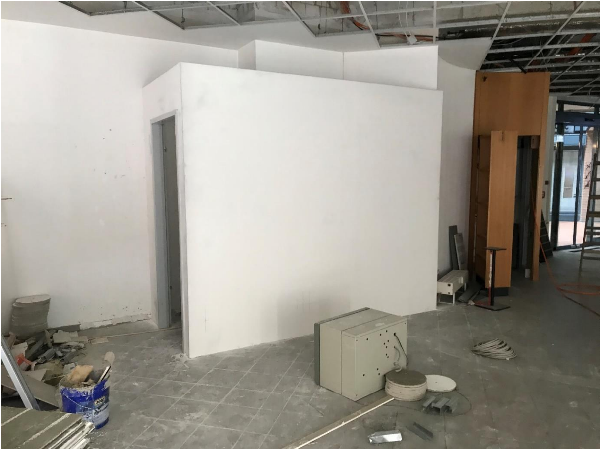
...und im Erdgeschoss wurde ein neuer Raum errichtet.
