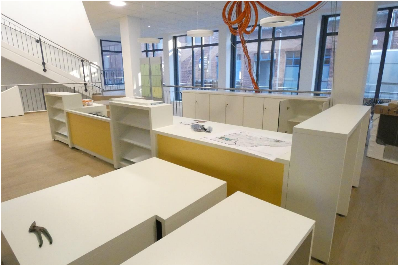
Aufbau der neuen Servicetheke im Erdgeschoss.
