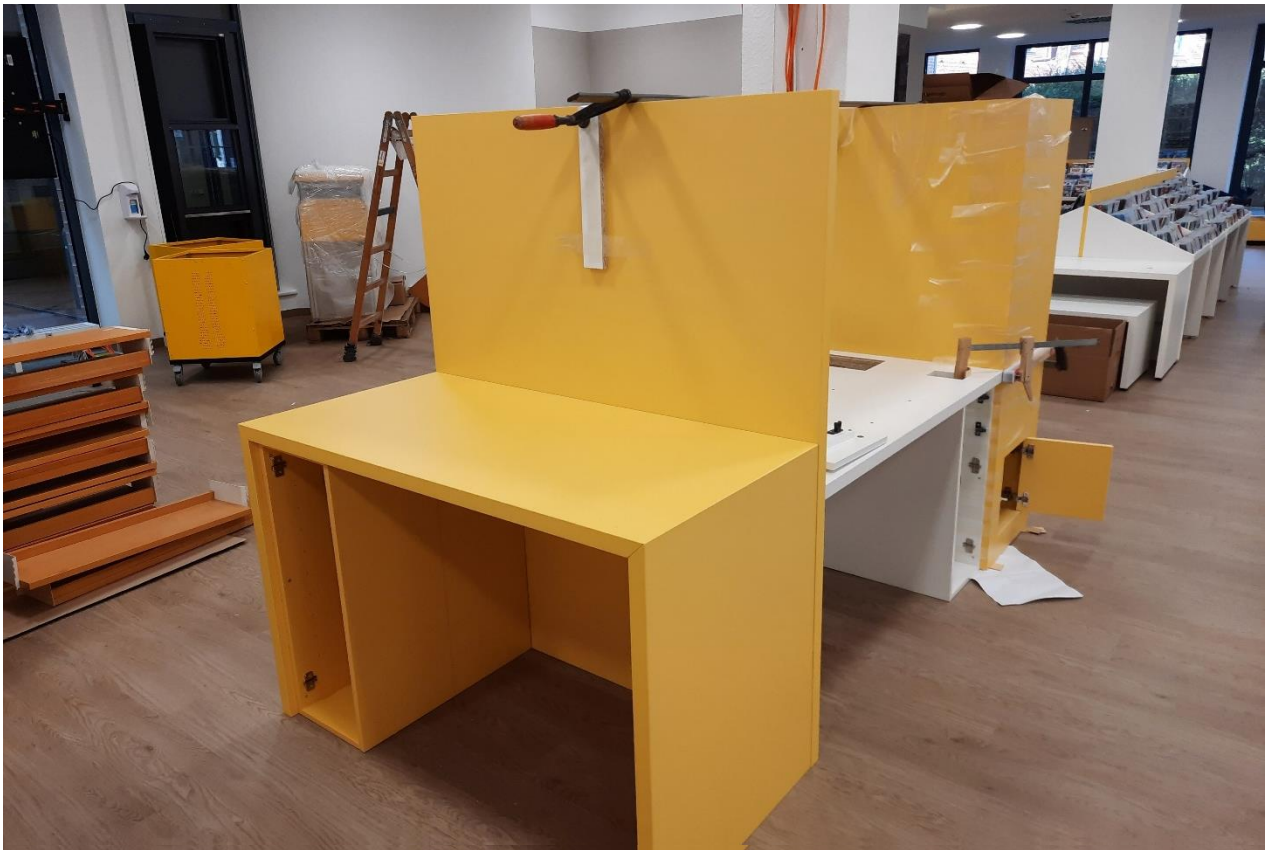
Das Gehäuse für die beiden Selbstverbucher und den Katalog wird aufgebaut.
